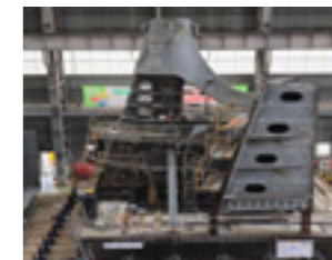
(11) S/Shell Plate 용접 및 NDE
