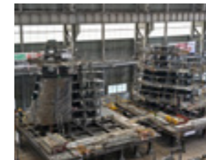
(7) S/Tube Pipe 준비 및 연결
