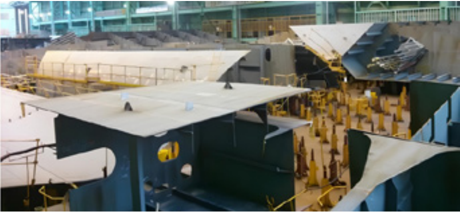
중조립은 평 블록, 곡 블록, 선체 상부구조 블록을 조립하는 3개의 과정으로 나뉩니다.
